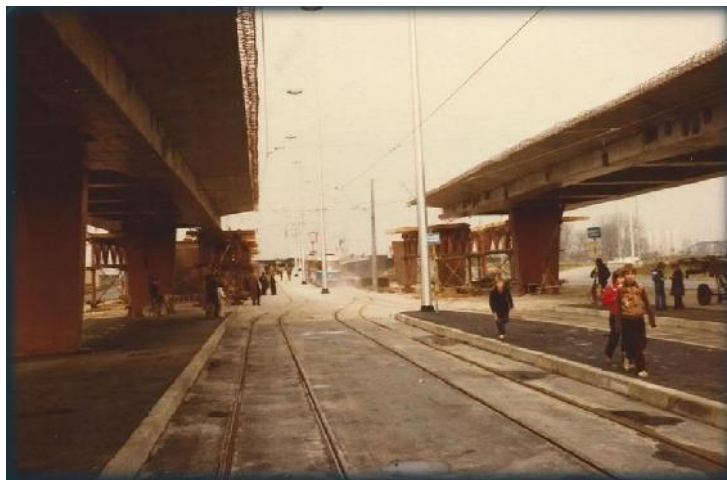
Slika 6. Izgradnja Mosta Mladosti 70-ih godina. Pogled prema sjeveru. [26]
