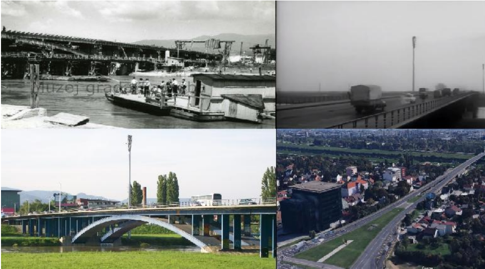
Slika 5. Izgradnja Mosta Slobode 1960-ih godina.. Pogled prema sjeveru. [25]
