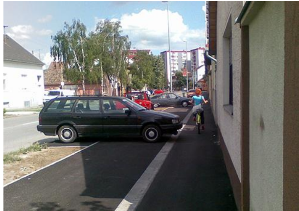
Slika 14. Nepovoljno vođenje biciklističkog traka uz parkirana vozila
