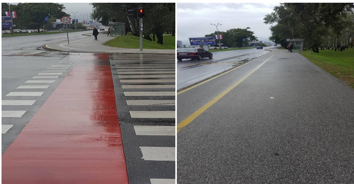
Slika 29. Prijelaz biciklističke staze preko autobusnog stajališta
