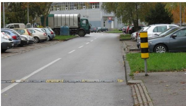
Slika 57. Primjer lošeg uspornika Izvor:[19]
