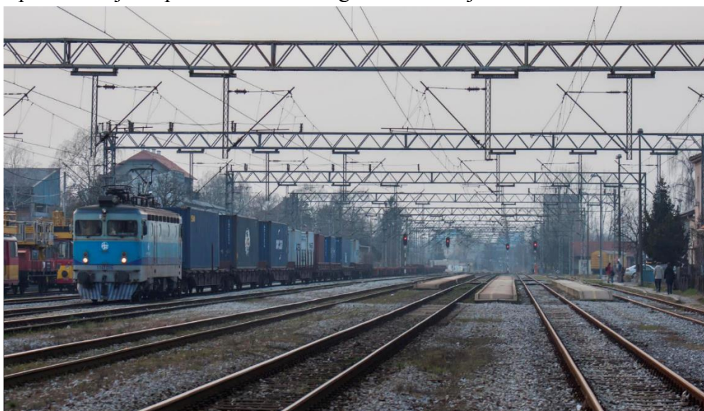
Slika 3. Pogled na kolodvor Sesvete iz smjera Dugo Selo
