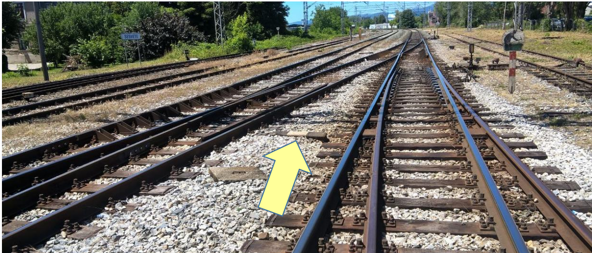
Slika 17. Mednik između drugog i trećeg kolosijeka
