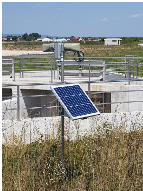
Slika 34. Prikaz zvučnih sirena na MZLZ
