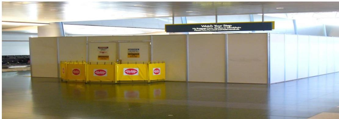
**Slika 9.** Zaštitni zidovi unutar terminala
