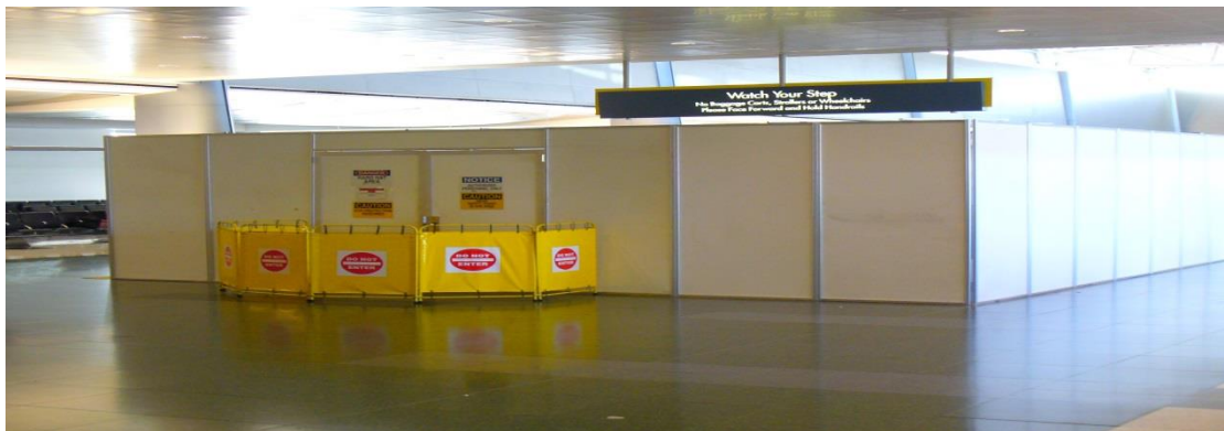
Slika 9. Zaštitni zidovi unutar terminala
