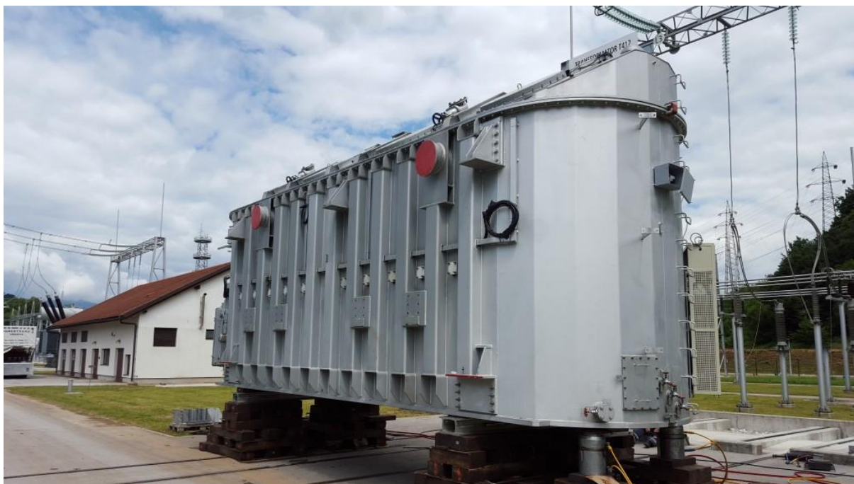
Slika 13 Transformator je iskrcan kod trafostanice Okroglo
