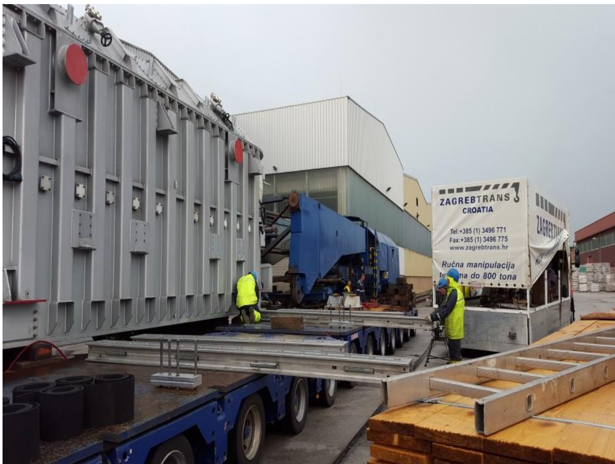
Slika 12 Ukrcaj transformatora na poluprikolicu
