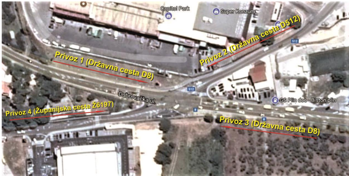
Slika 27. Raskrižje Dubrovačke ulice i Ulice Stjepana Ivičevića prije rekonstrukcije
