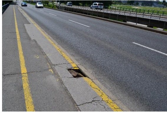
Slika 19. Neodržavana biciklistička staza na Mostu slobode
