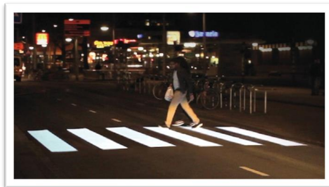
Slika 2: Podno osvjetljenje pješačkog prijelaza [8]
