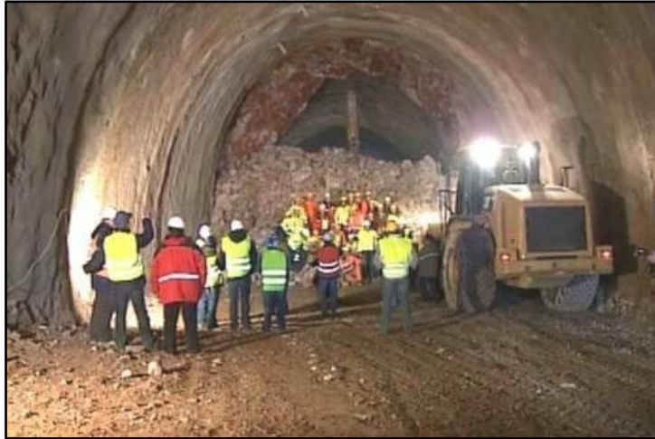
Slika 13: Probijen posljednji tunel na dionici Rijeka - Zagreb
