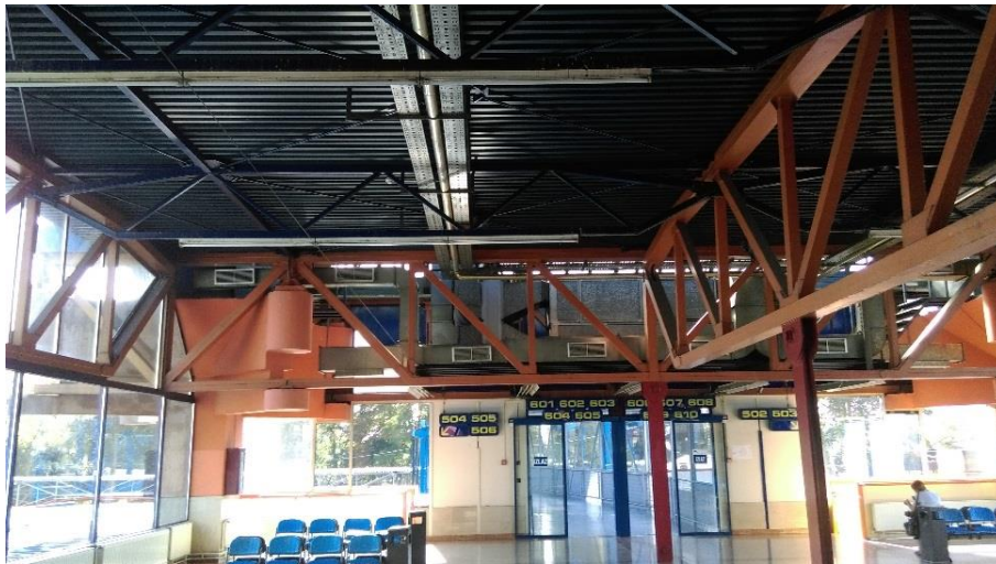
Slika 6.2. Dio postojeće konstrukcije krova čekaonice na autobusnom kolodvoru
