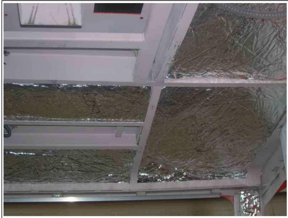
Slika 9. Toplinsko zvučna izolacija prije postavljanja oplata od perforiranog aluminijskog lima
