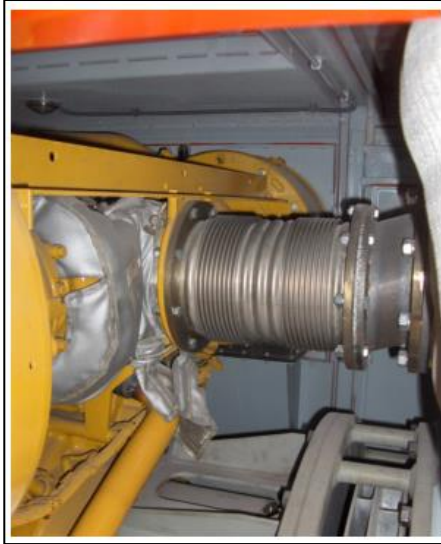
Slika 19. Spoj ispuha motora na ispušni lonac
