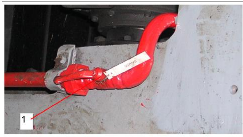
Slika 29. Slavina za zatvaranje napajanja goriva dizel motora (1)
