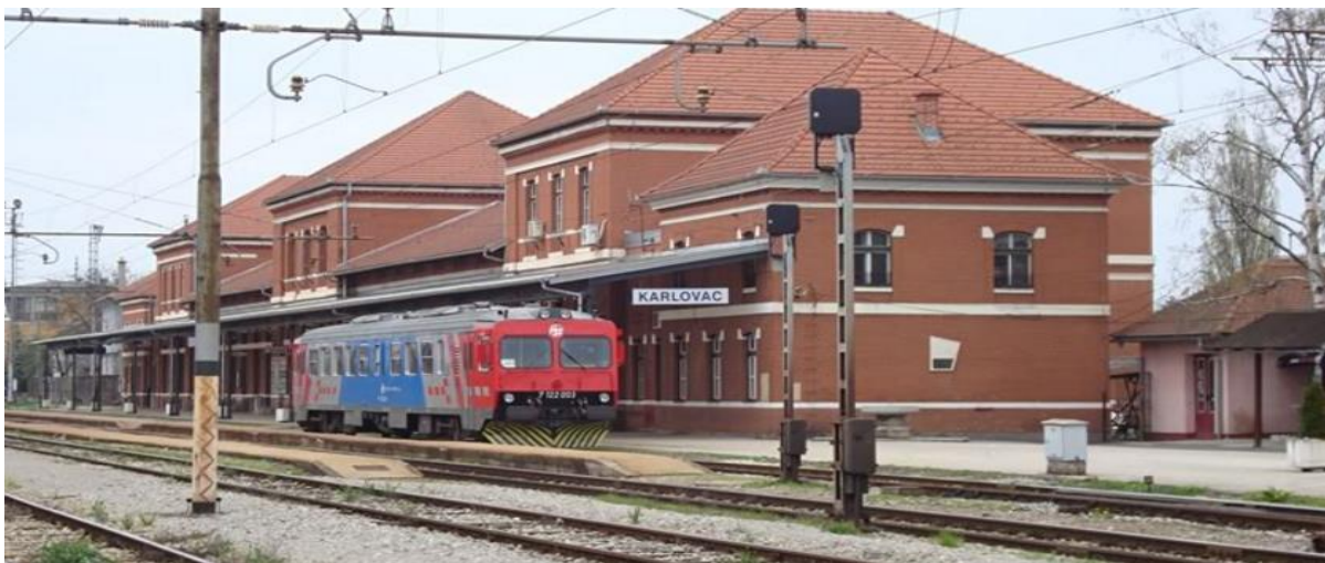
Slika 26. Željeznički kolodvor Karlovac [49]
