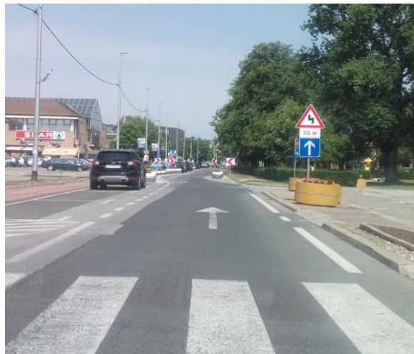
Slika 63. Nepotrebno iscrtana strelica na kolniku
