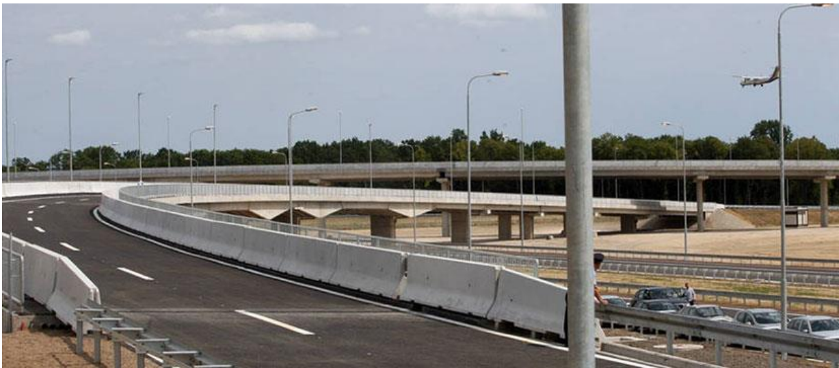
Slika 13. Betonska zaštitna ograda New Jersey
