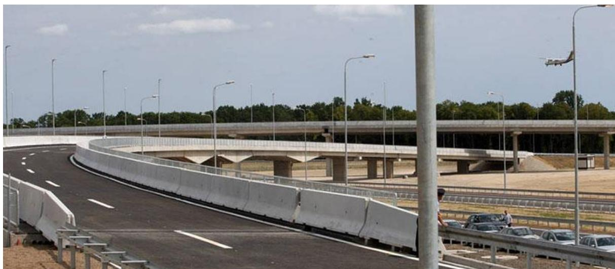
Slika 13. Betonska zaštitna ograda New Jersey
