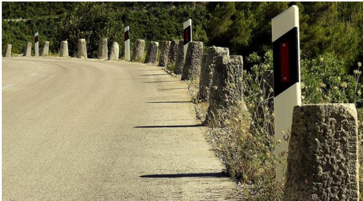
Slika 11. Kolobrani - betonski stupići
