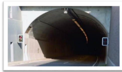
Slika 11. Izlazna zona tunela, [11]
