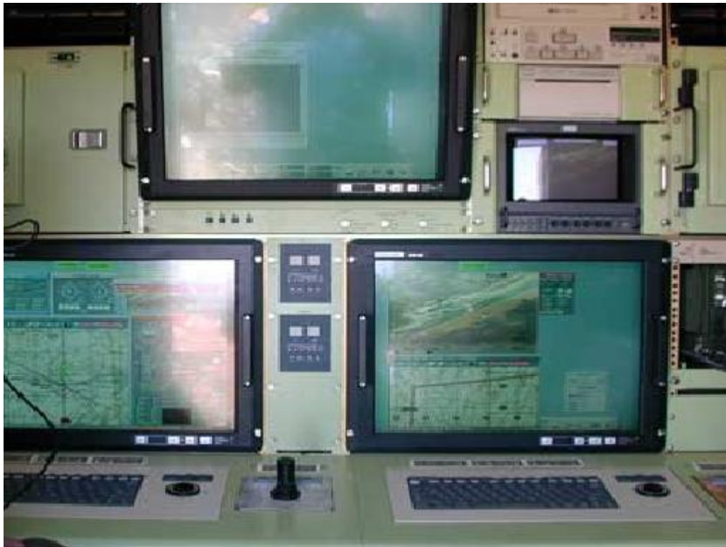
Slika 17. Unutrašnjost upravljačke jedinice, [11]
