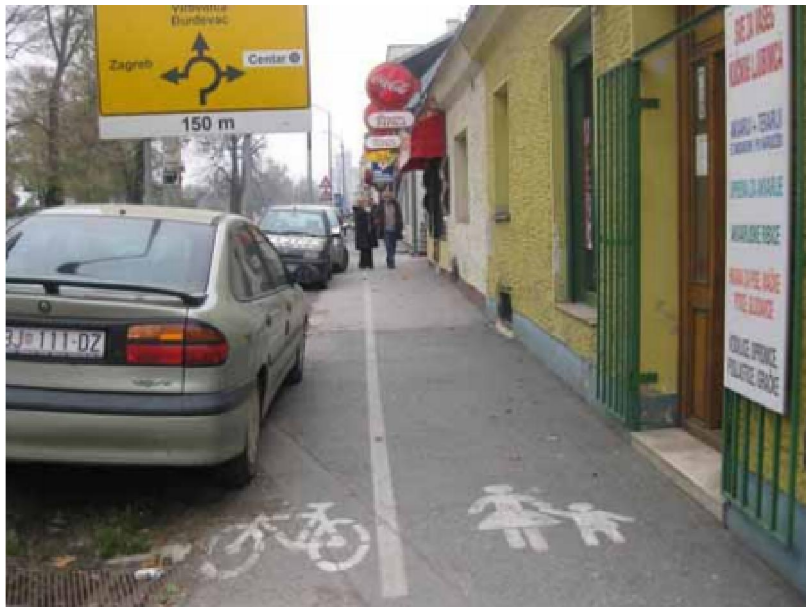
Slika 24. Loše izvedena biciklistička staza u Bjelovaru [19]
