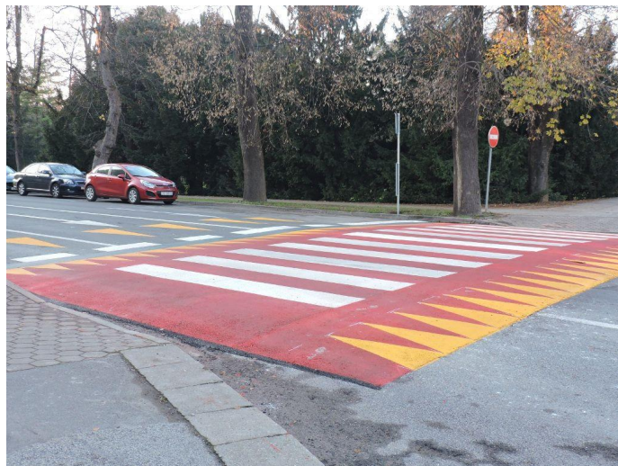
Slika 18. Uzdignuta ploha s pješačkim prijelazom u Varaždinu [19]
