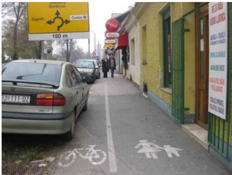
Slika 24. Loše izvedena biciklistička staza u Bjelovaru [19]
