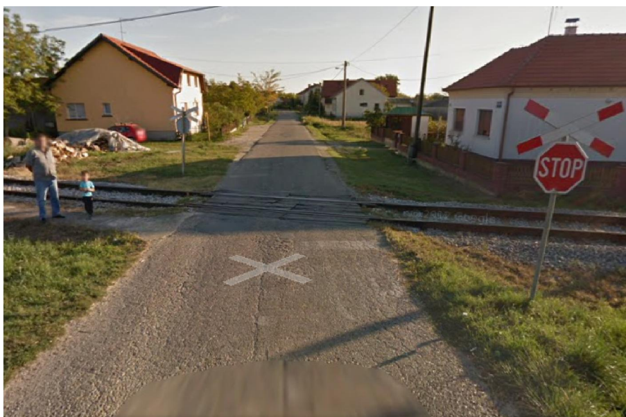
Slika 21. Željezničko-cestovni prijelaz u Starim Plavnicama[17]
