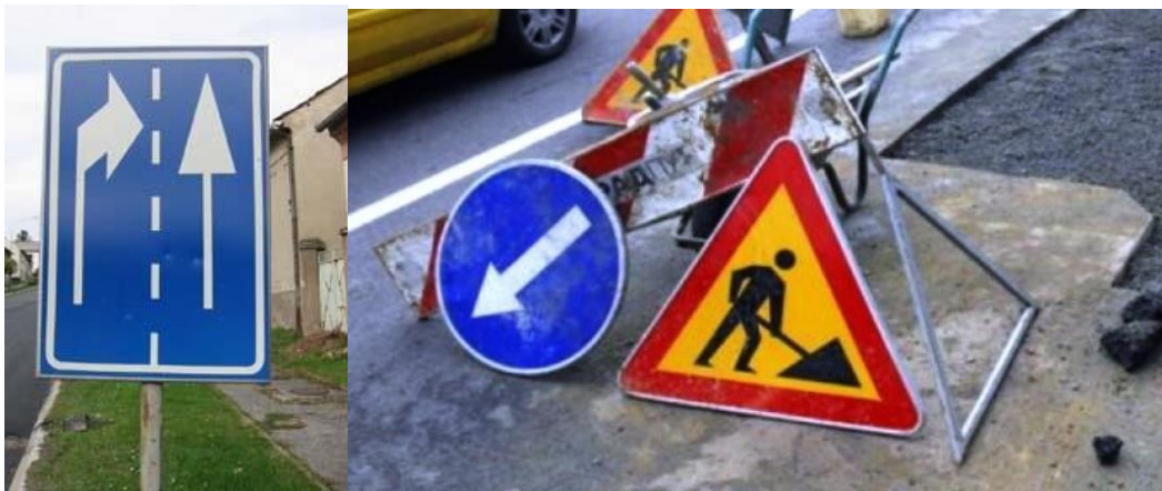
Slika 34. Npropisan prometni znak prestrojavanja i obilježavanja radova na cesti [17]
