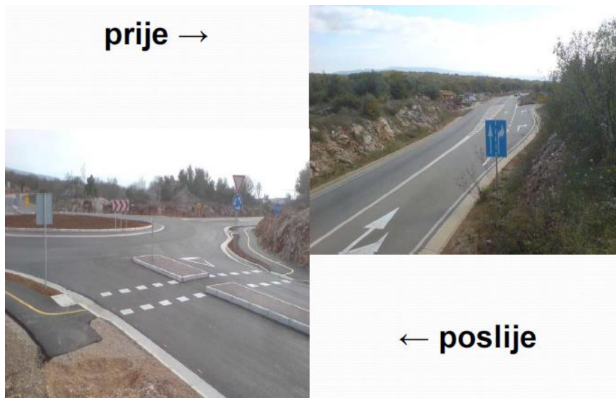
Slika 51. Prikaz sanacije opasnog mjesta izgradnjom rotora (23)
