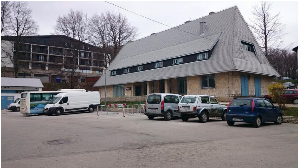
Slika 10. Zgrada tehničke službe i službe održavanja voznog parka
