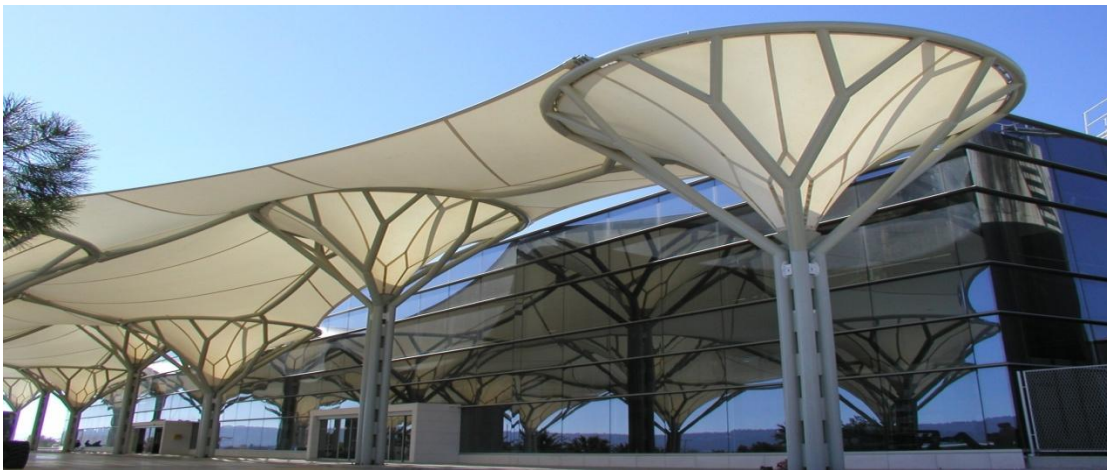
Slika 4.1. Vanjski izgled putničkog terminala ZLS
