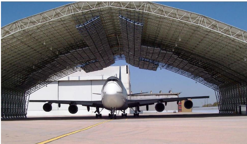
Slika 10. Hangar za odleđivanje zrakoplova infracrvenom tehnologijom
