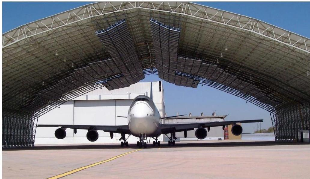
*Slika 10. Hangar za odleđivanje zrakoplova infracrvenom tehnologijom*
