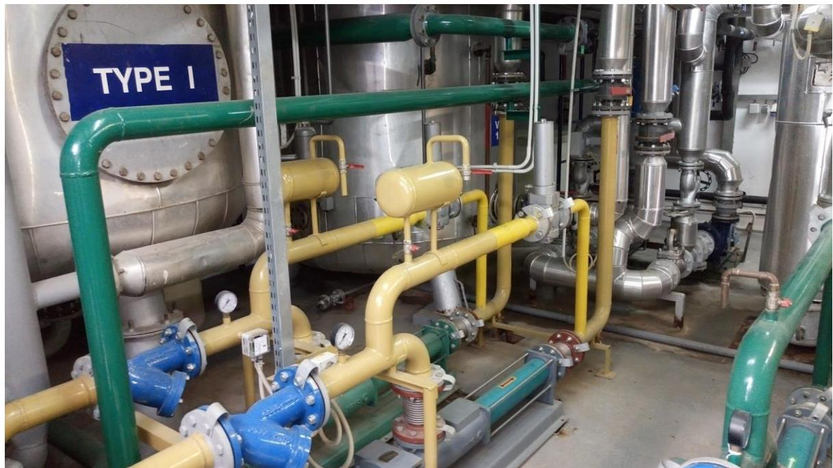
Slika 9. Postrojenje za prijenos tekućina za odleđivanje i zaštitu zrakoplova od zaleđivanja na MZLZ
