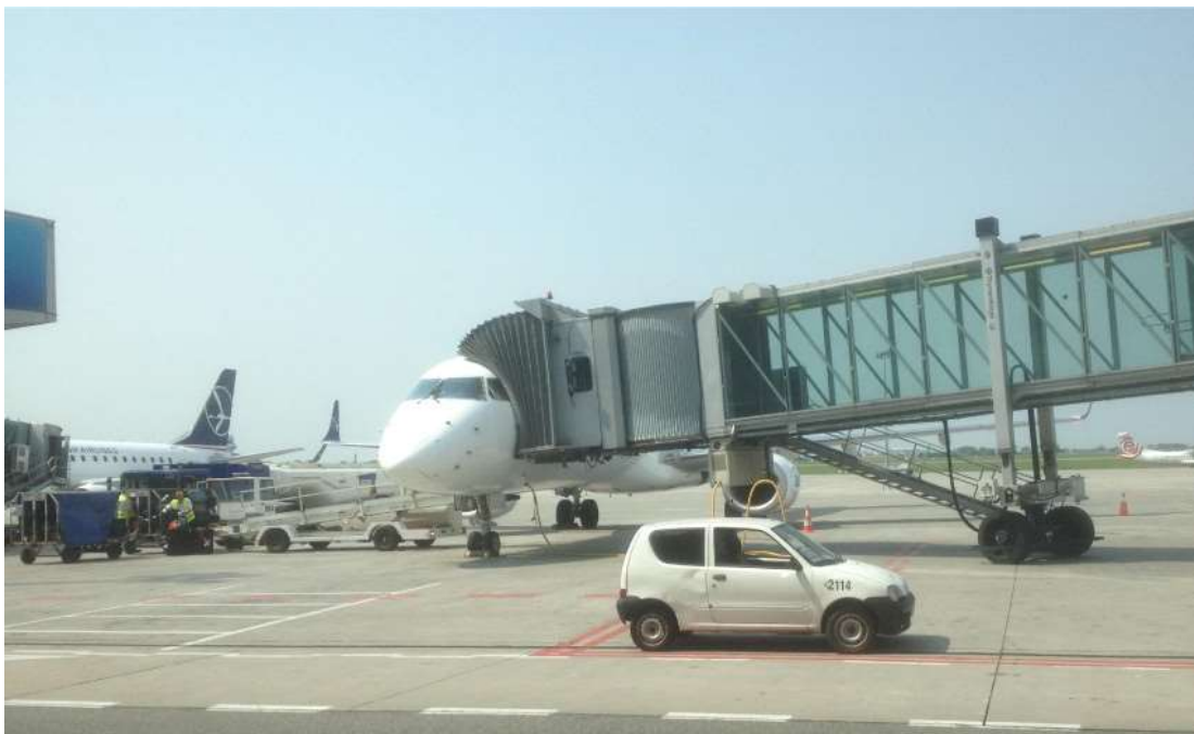
Slika 4.- Prikaz zračnog mosta spojen na zrakoplov
