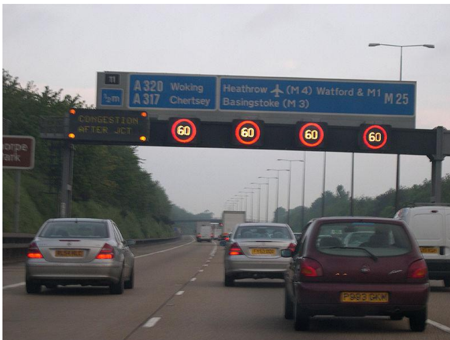
Slika 6. Prikaz VSL sustava implementiranog u okolici Londona
