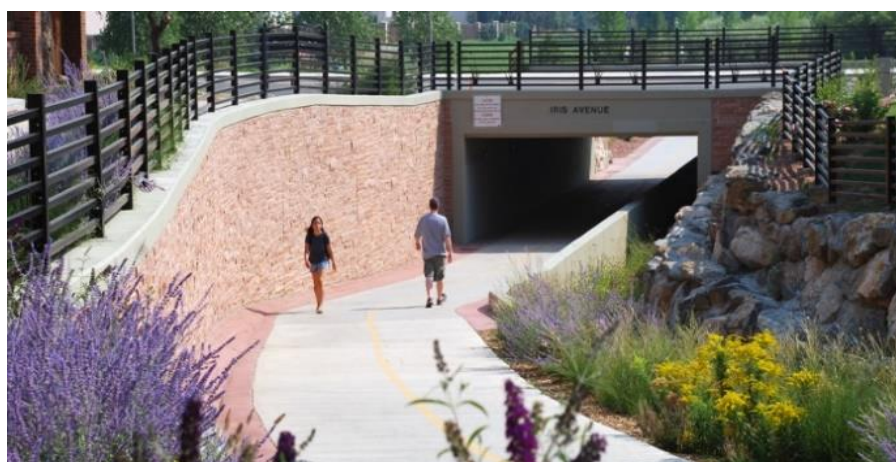
Slika 11. Primjer pothodnika u Boulder, Colorado, USA [24]
