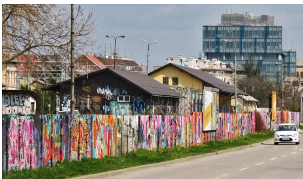
Slika 4. Zid od betonskih blokova uzduž Magazinske ulice [17]
