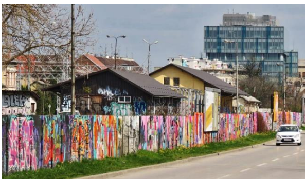
Slika 4. Zid od betonskih blokova uzduž Magazinske ulice [17]
