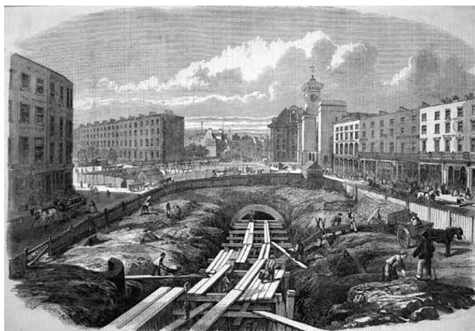
Slika 33. Izgradnja podzemne željeznice u Londonu
