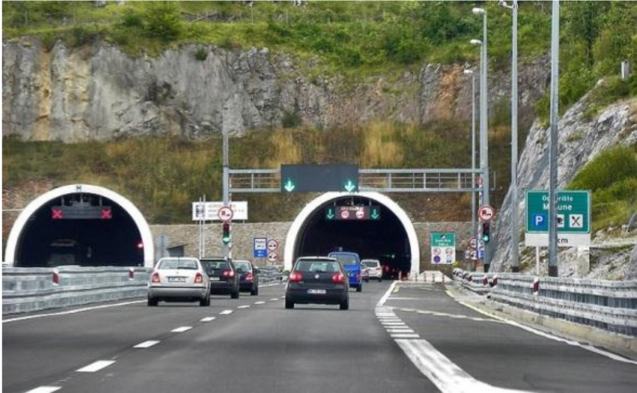
Slika 20. Južni ulazni portal tunela Sveti Rok s opremom i signalizacijom Izvor: [9.]
