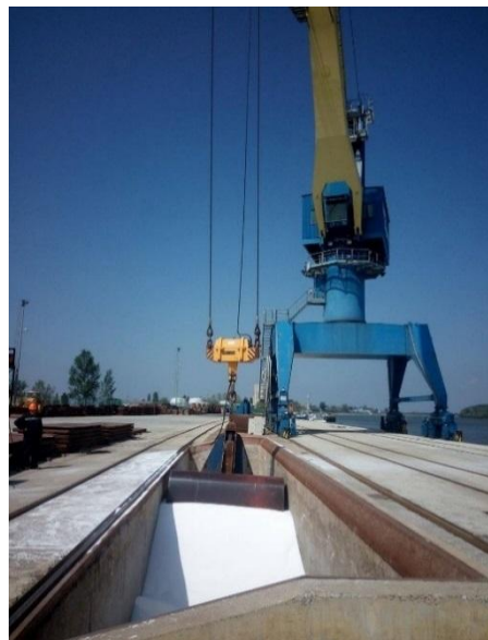
Slika 25. Dizalica za prekrcaj rasutih i generalnih tereta Gottwald HMK 170
