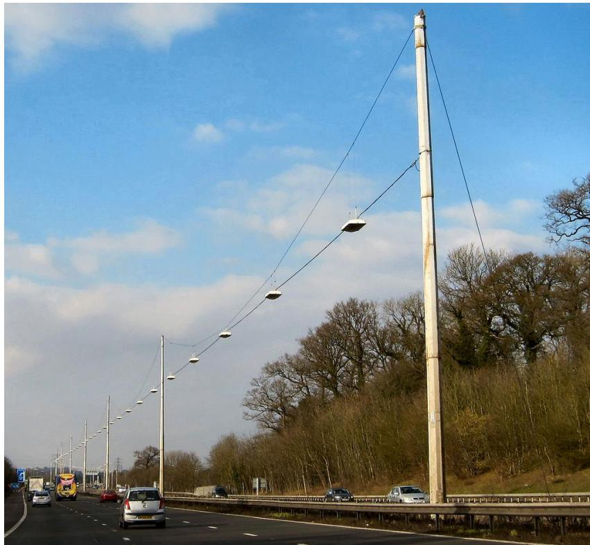
**Slika 13.** Osnni raspored izvora svjetlosti s nosivim žicama uzdužno na os ceste
