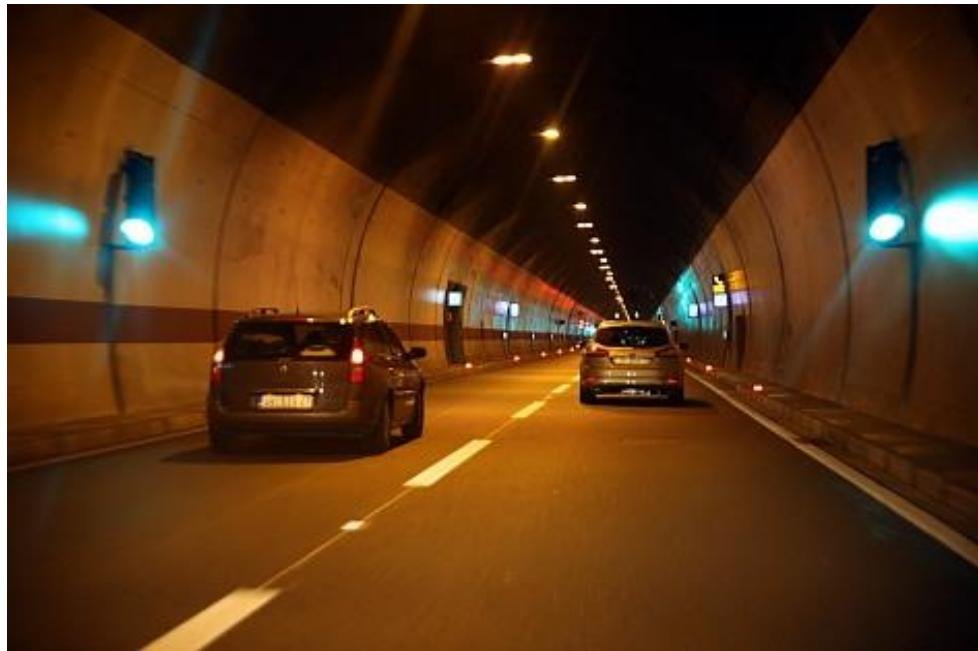
**Slika 14.** Centralni raspored rasvjete u tunelu
