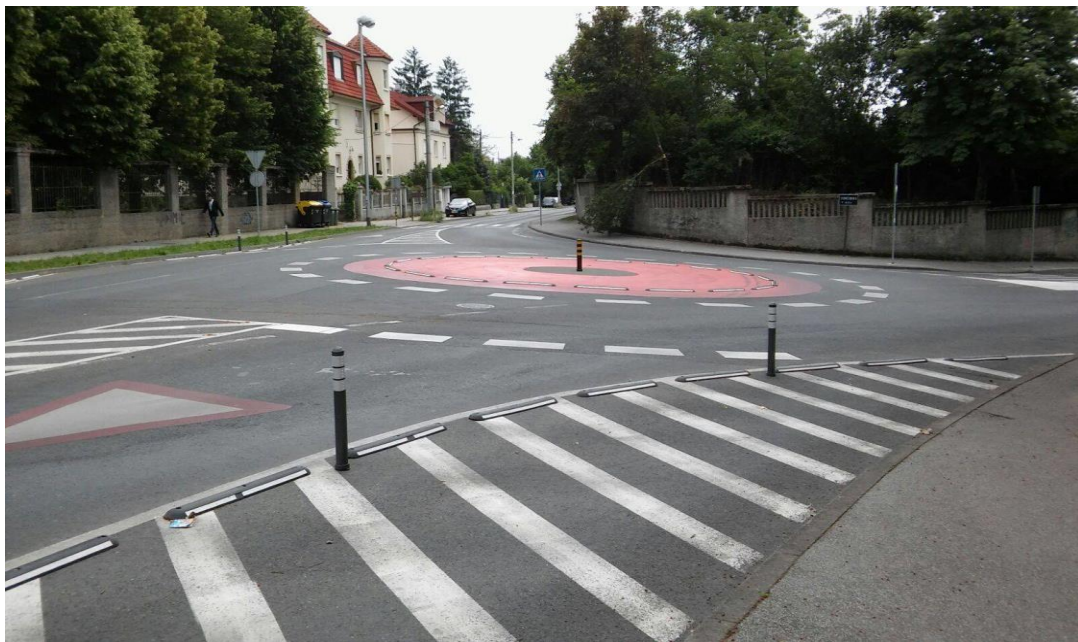
Slika 26. Montažno RKT - om prometa Vončinina ulica - Voćarska ulica
