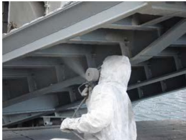
Slika 15. Nanošenje premaza bezračnim prskanjem
