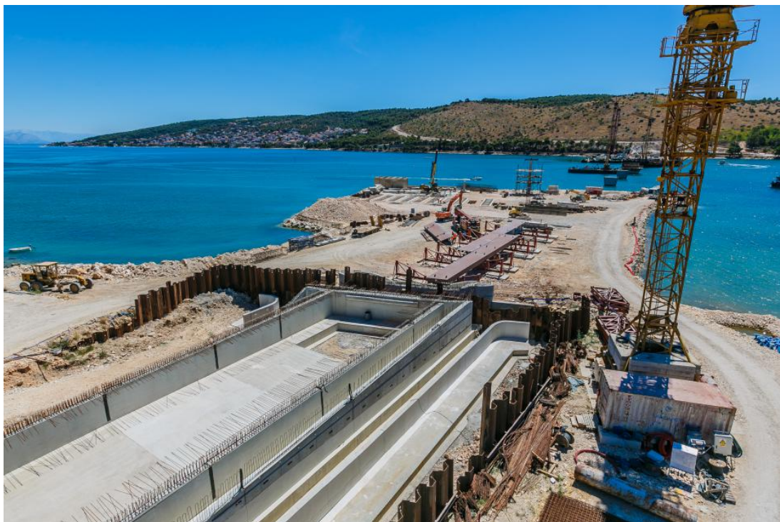
Slika 17. Fotografski prikaz gradilišta – kolovoz 2016. godine
