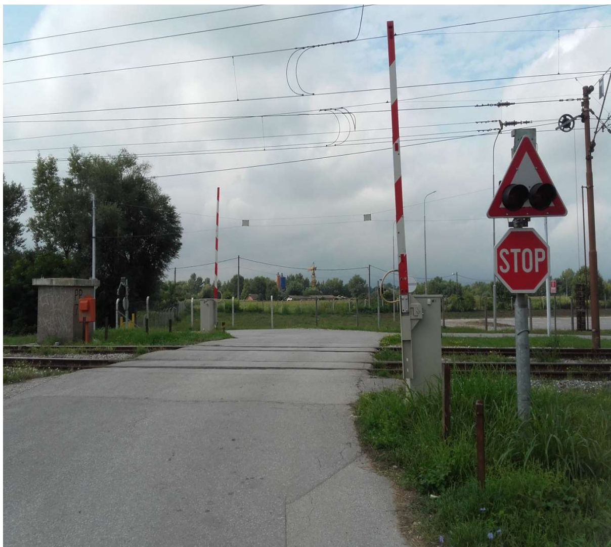
Slika 9. Željezničko – cestovni prijelaz broj 76
