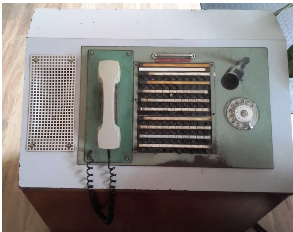
Slika 12. Telekomunikacijski pult u prometnom uredu kolodvora Zaprešić
