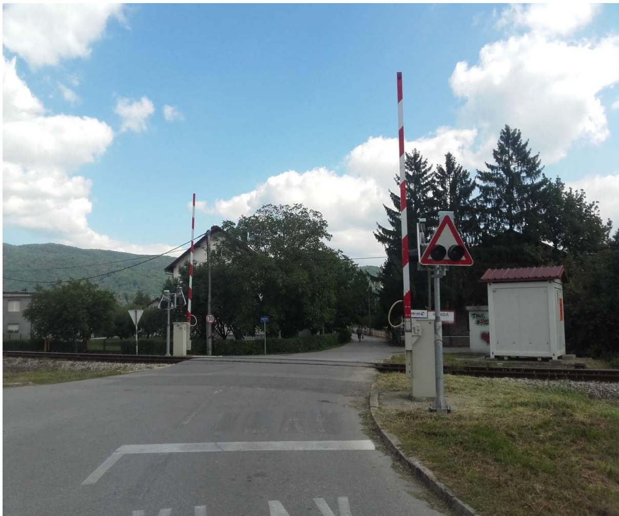
Slika 11. Željezničko – cestovni prijelaz broj 76 A1
