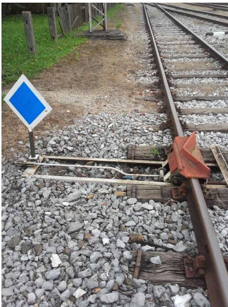
Slika 6. Iskliznica broj 5 u kolodvoru Zaprešić
