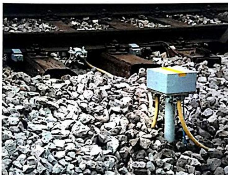
*Slika 24. Kontrolni elektronički sklop vanjskog uređaja VUR u kutiji uz kolosijek (Altrpro) [2].*
