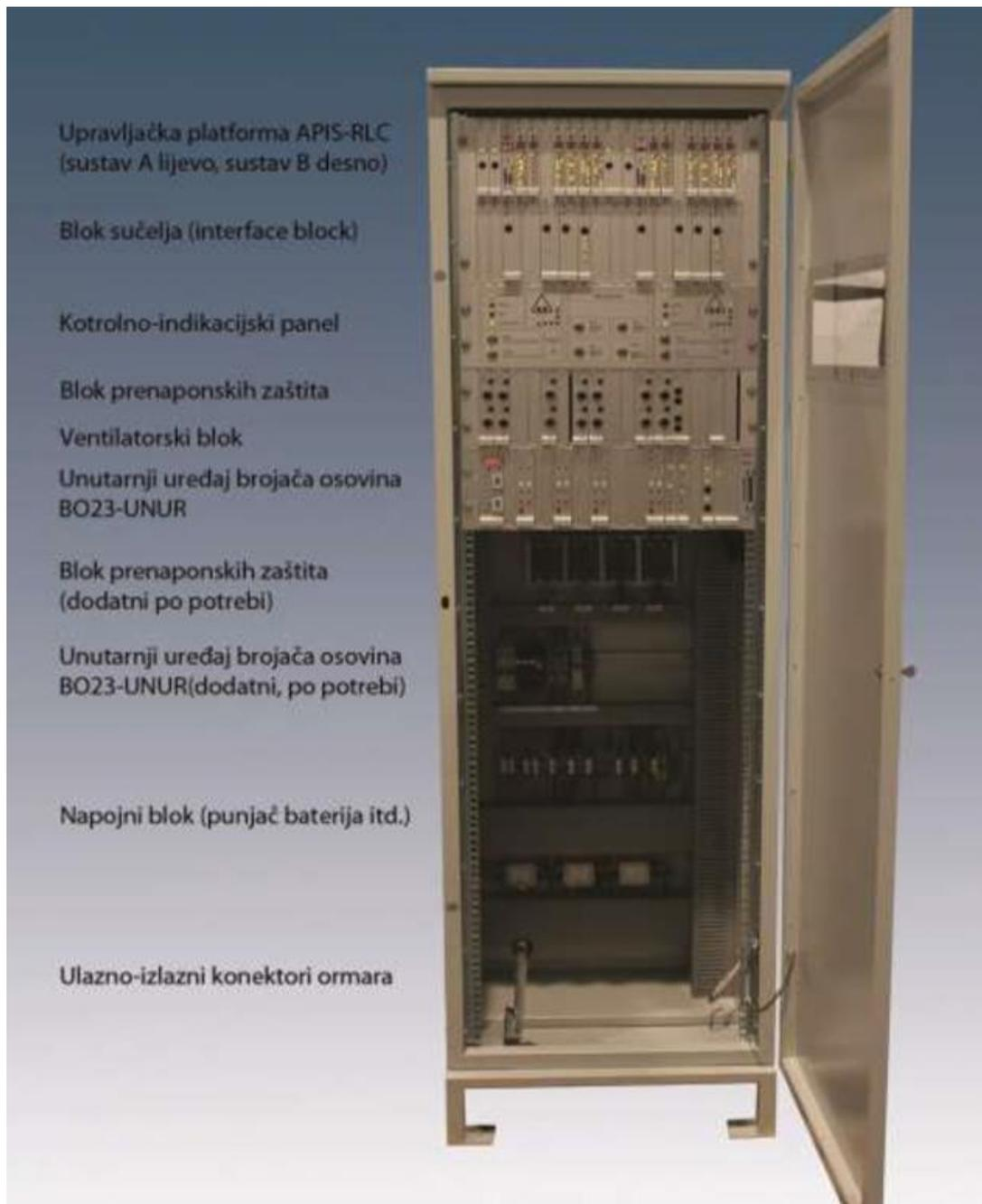
*Slika 3. Smještaj opreme na upravljačkom ormaru ŽCPR-a RLC23 [2].*
