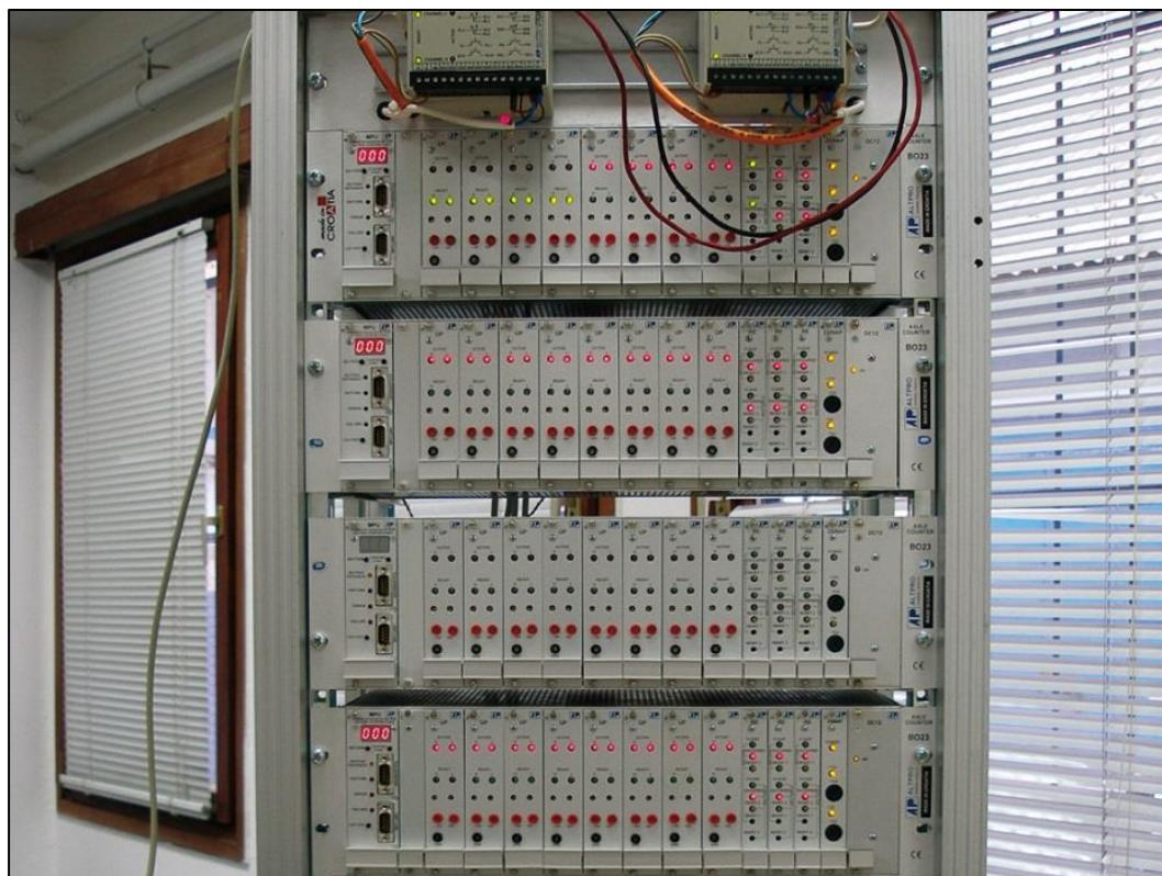
Slika 17: Prikaz više primjeraka unutarnjeg sklopolija brojača osovina BO23 (UNUR)
