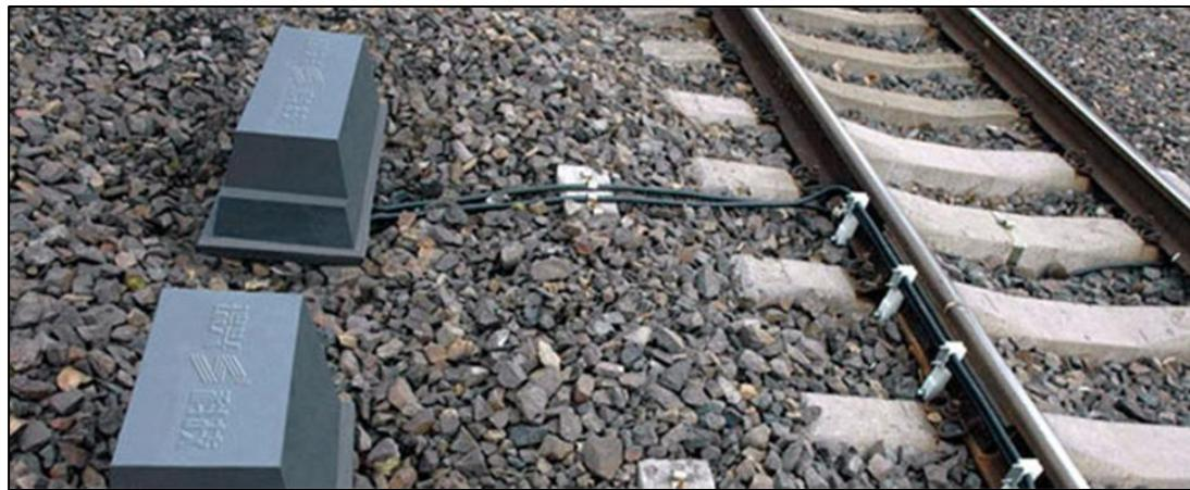
Slika 4: Oprema izoliranih odsjeka
