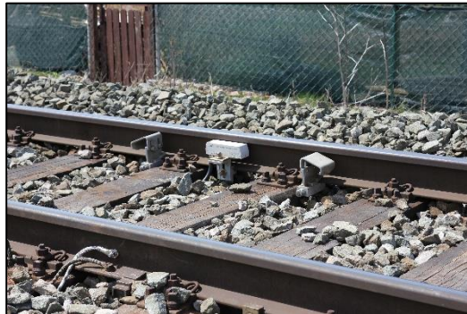
Slika 15: Prikaz senzora ZK24-2
