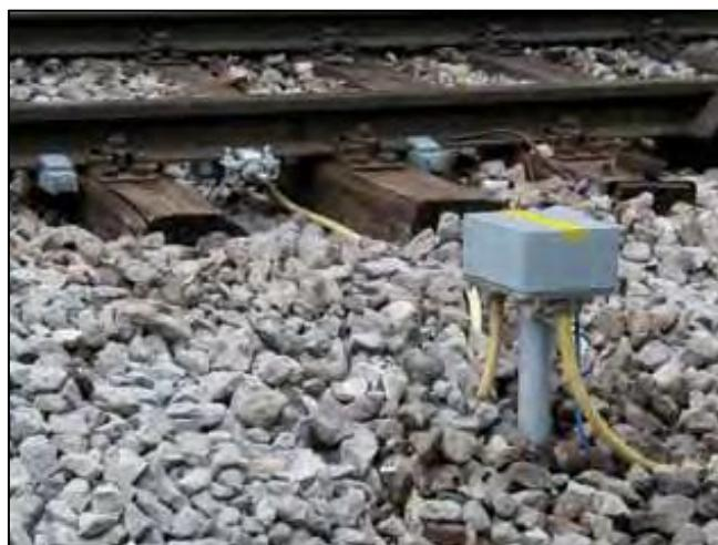
Slika 13: Prikaz kućišta vanjske elektronike (VUR)
