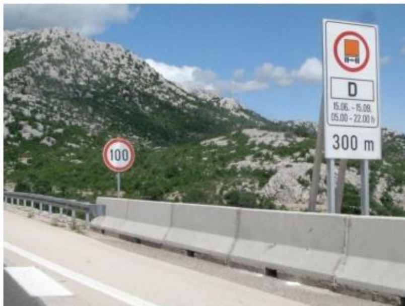
Slika 13. Prometni znak za ograničavanje prijevoza kroz tunel na autocesti A1, [22]
