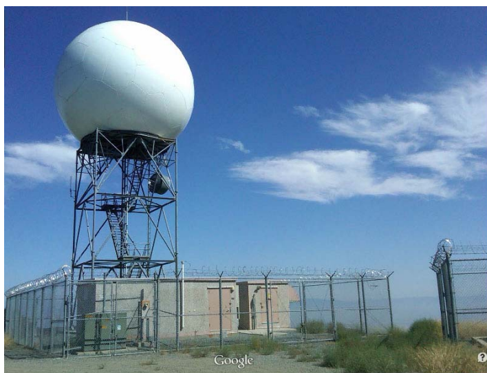
Slika 22. Nexrad meteorološki radar
