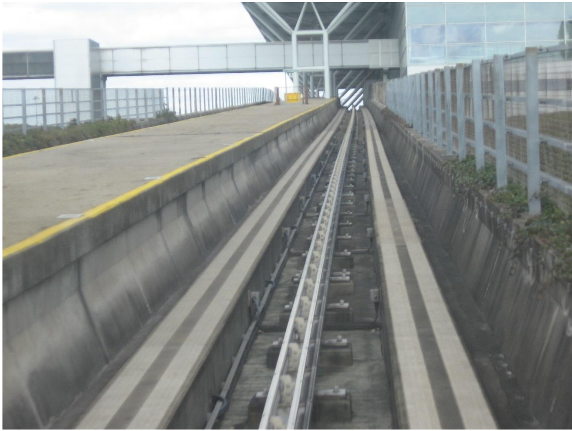
Slika 6. Prikaz gornjeg ustroja pruge s trećom tračnicom u sredini
