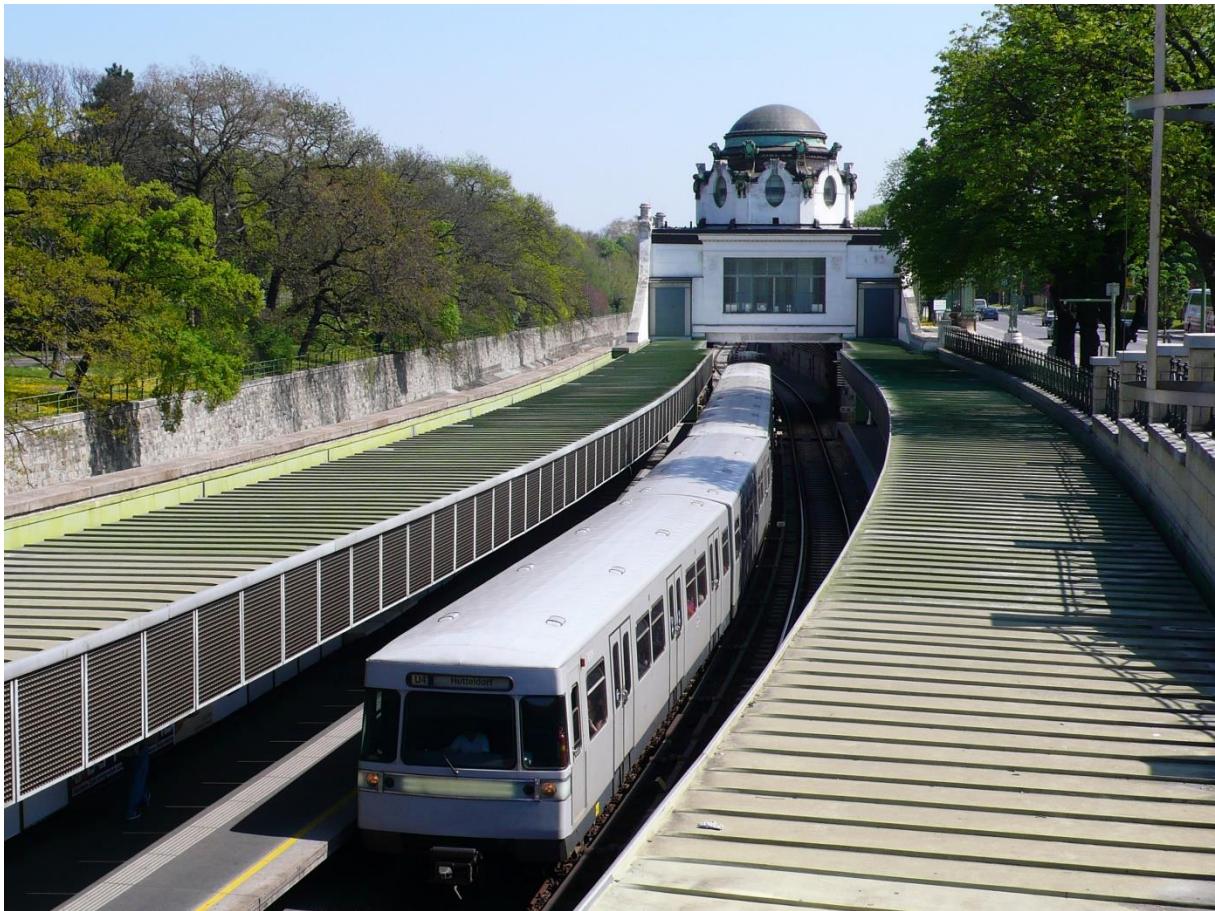
Slika 5. Prikaz metroa upuštenog u teren s otvorenim iskopom - Beč
