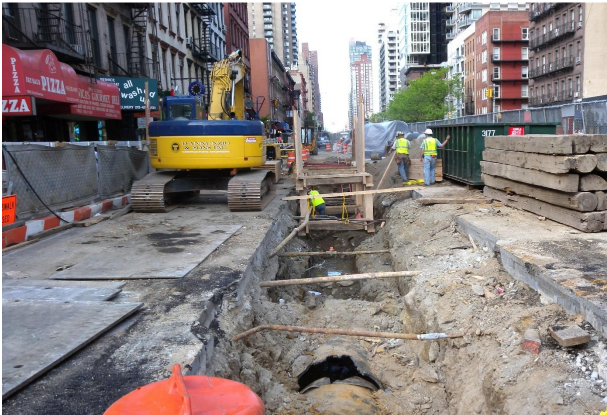
Slika 2. Prikaz radova na ulici prilikom izgradnje metroa
