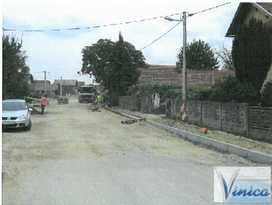
Slika 12. Izgradnja pješačke staze
