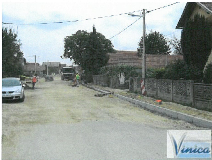
Slika 12. Izgradnja pješačke staze
