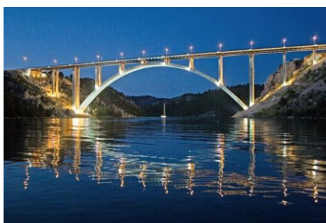
Slika 4. Most Krka (primjer lučnog armiranobetonskog mosta)
