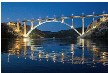
Slika 4. Most Krka (primjer lučnog armiranobetonskog mosta)
