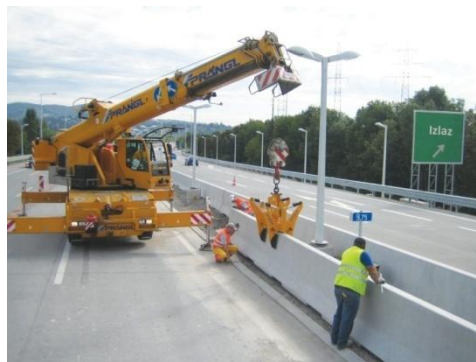
Slika 7. Postavljanje betonske zaštitne ograde tipa New Jersey u razdjelnom pojasu
