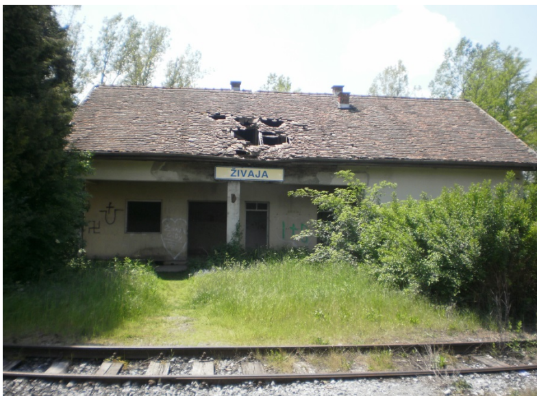
Slika 28: Kolodvorska zgrada u nezaposjednutom kolodvoru Živaja
