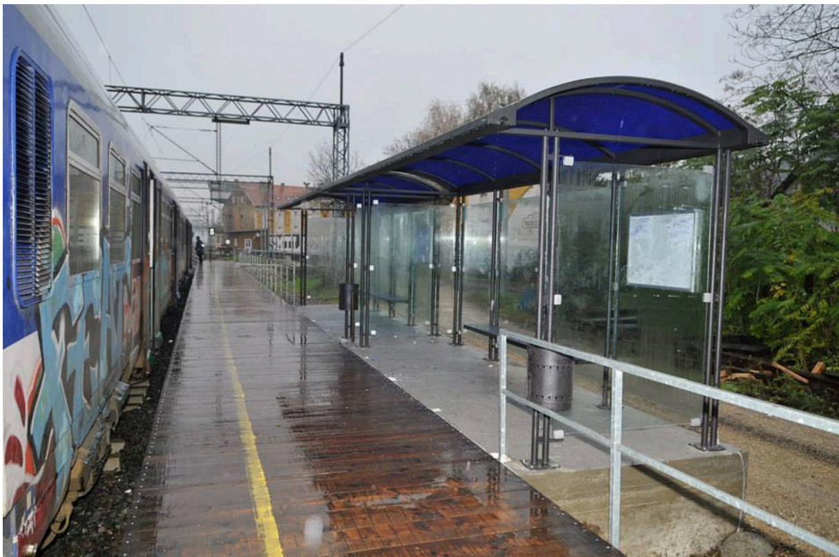
Slika 19: Privremeni montažni peron pored četvrtog kolosijeka, kolodvor Sisak
