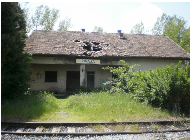
Slika 28: Kolodvorska zgrada u nezaposjednutom kolodvoru Živaja
