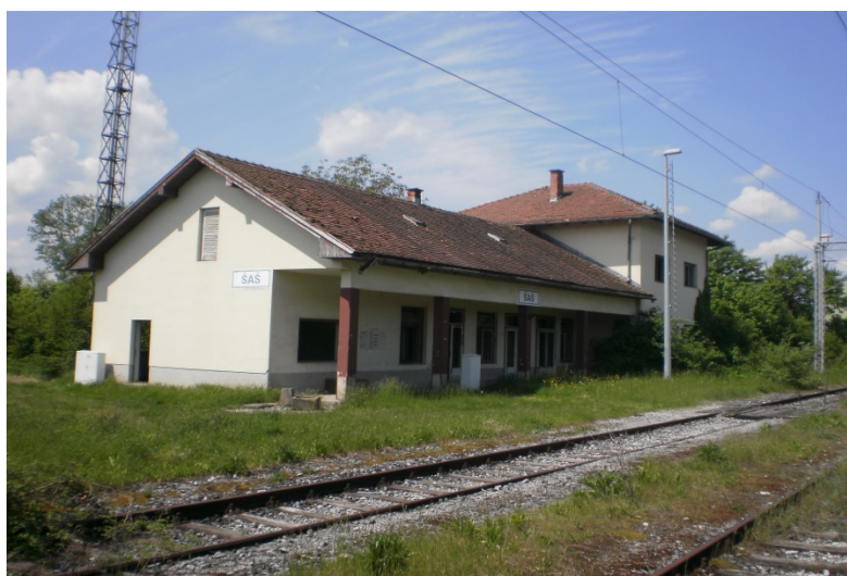
Slika 26: Kolodvorska zgrada u nezaposjednutom kolodvoru Šaš
