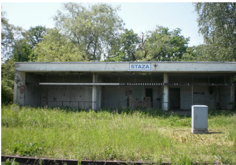
Slika 24: Kolodvorska zgrada u nezaposjednutom kolodvoru Staza
