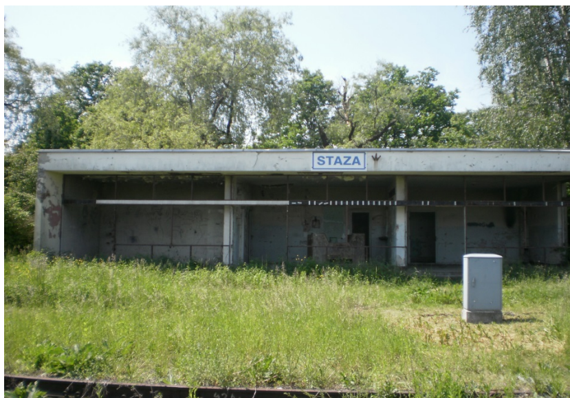
Slika 24: Kolodvorska zgrada u nezaposjednutom kolodvoru Staza
