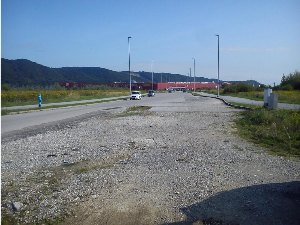
Slika 6. Pogled s raskrižja prema West Gate-u
