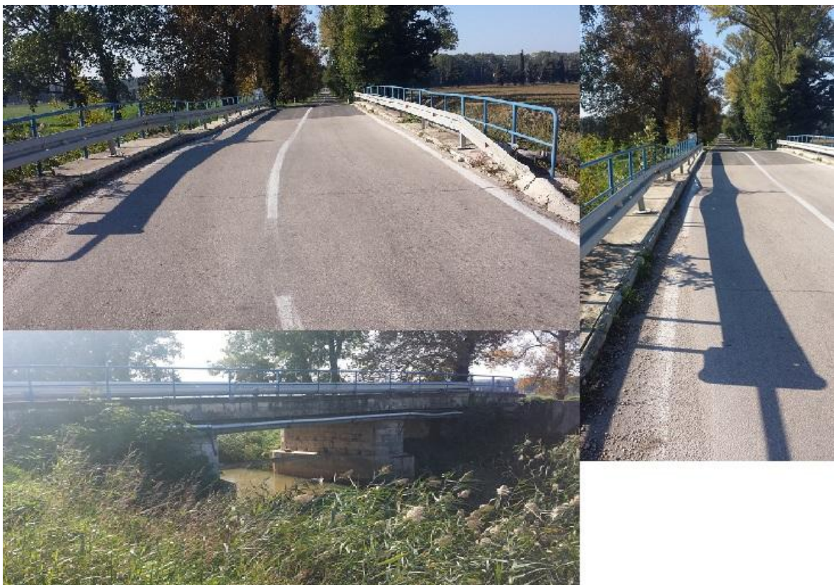
Slika 6.7. Postojeće stanje mosta “Jankolovica”
