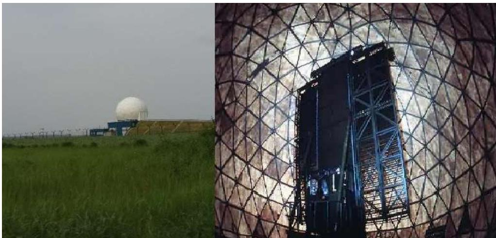
**Slika 29.** Vanjski izgled radara AN/FPS 117 te pogled na radar iz unutrašnjosti radarske kupole [14]
