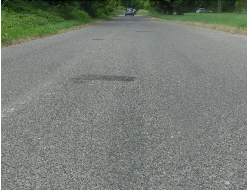
Slika 19. Prikaz asfaltne podloge na kojoj je provođeno testiranje, [19]
