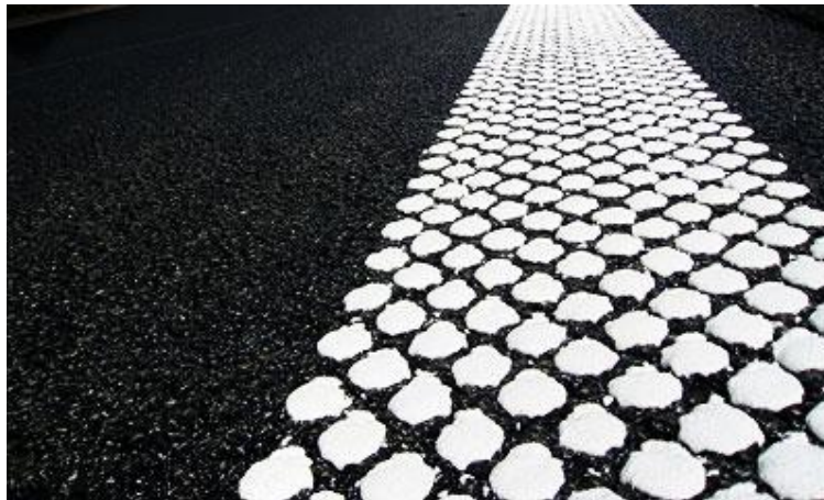
Slika 16. Oznaka od termoplastike
