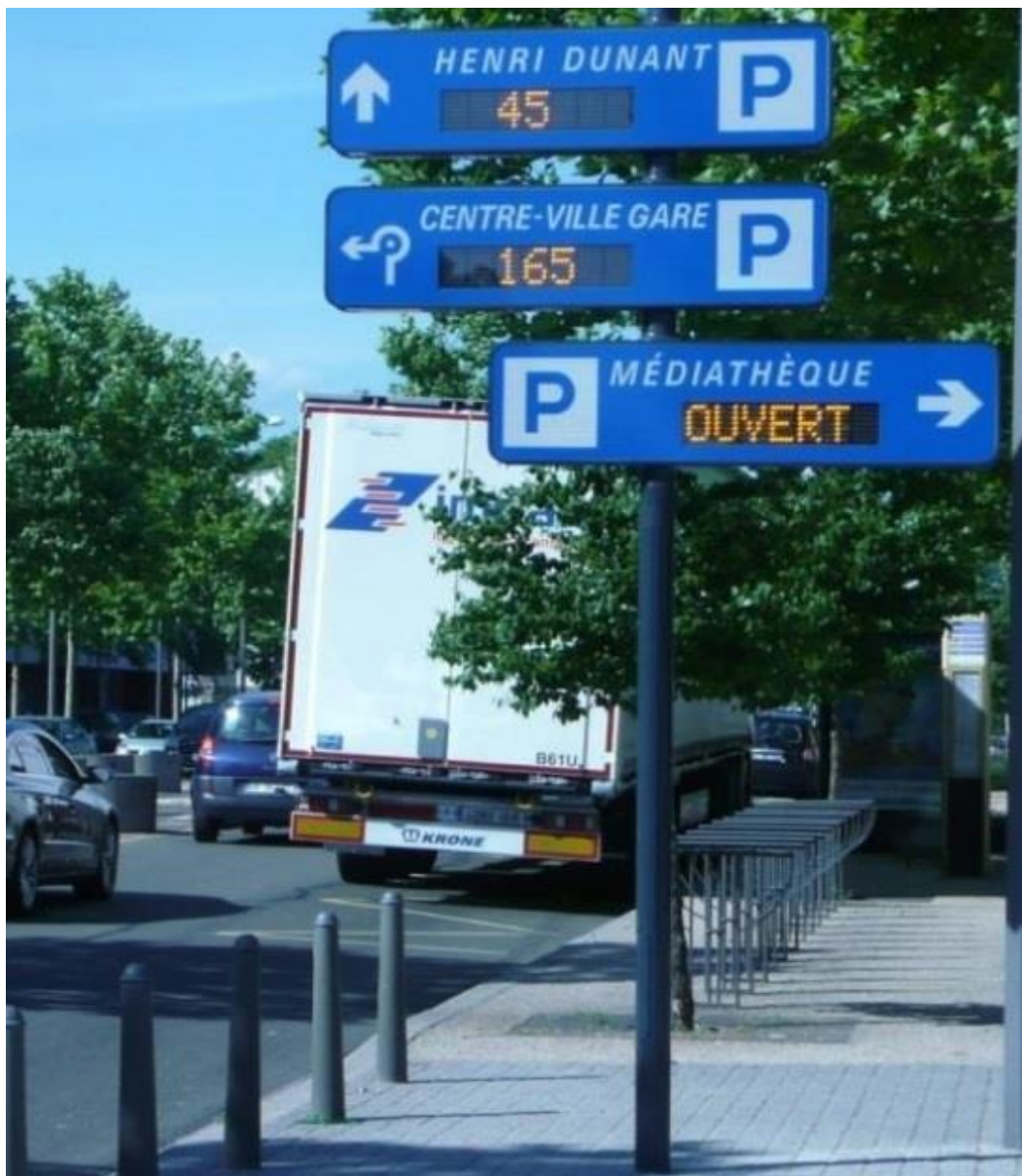
Slika 17. Elektronički sustav za navođenje smješten na ulici Les Mureaux-a (Francuska)
