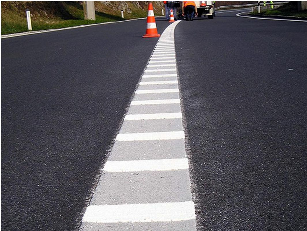
Slika 5. Razdjelna (središnja) crta s „vibro-efektom“, izvor [12]
