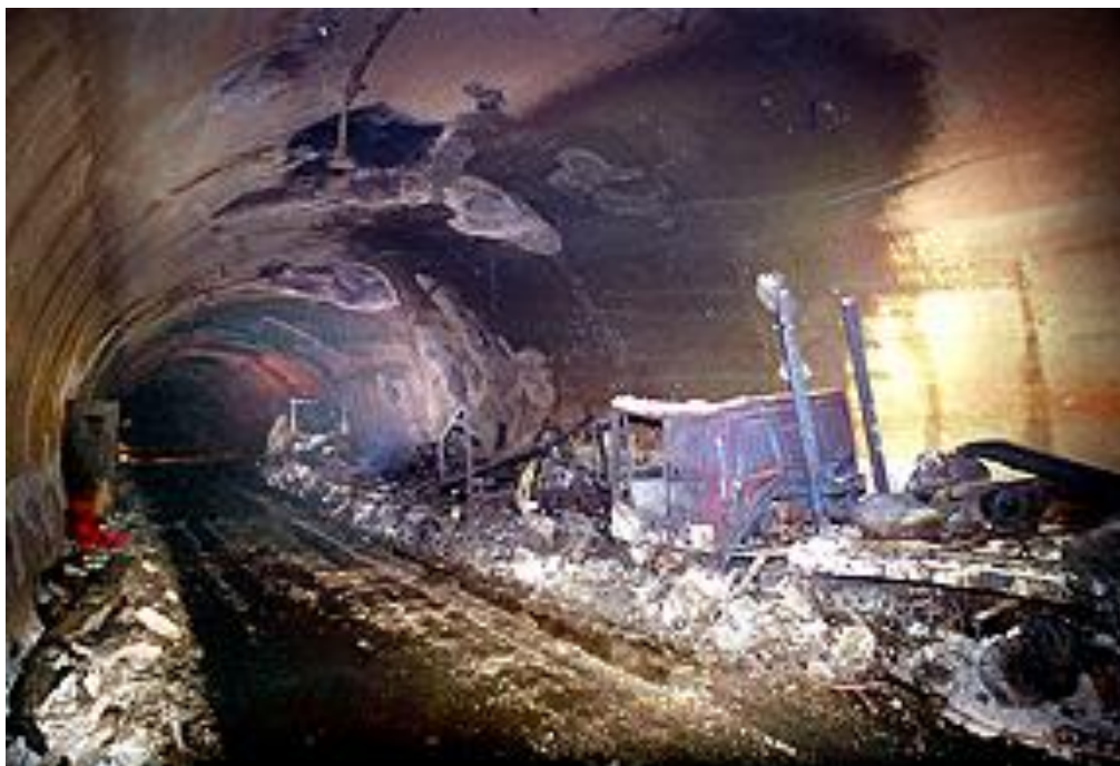
Slika 2. Posljedice požara u tunelu Mont-Blanc, izvor [10]
