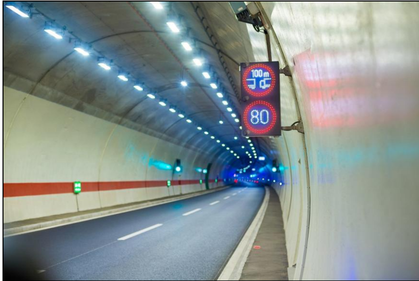
Slika 37. Svjetlosni promjenjivi znakovi (SPZ), izvor [13]
