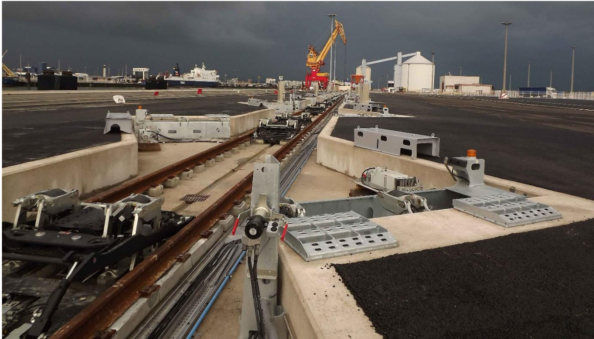
Slika 6 Željeznica za niskopodne vagona za prijevoz poluprikolica, [24]
