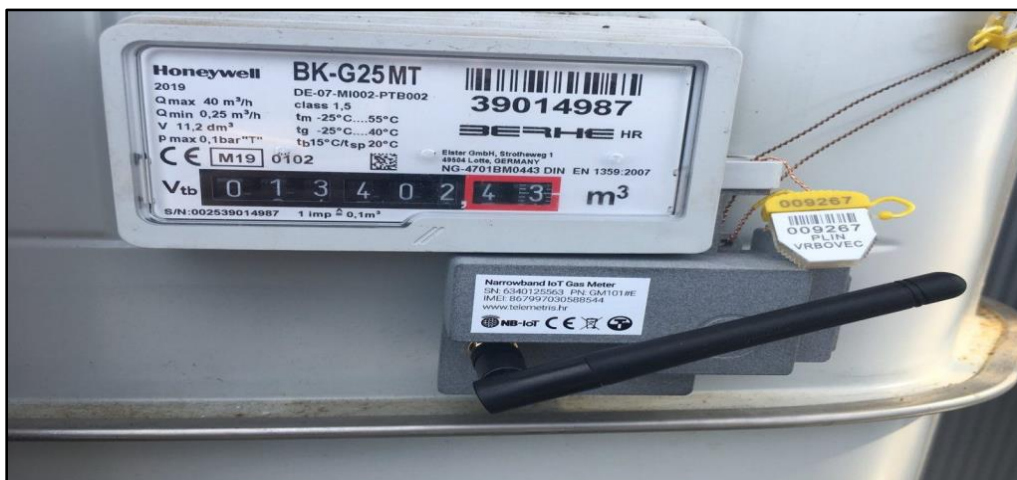
Slika 19. Uređaj za daljinsko očitavanje brojila. Izvor: [11]
